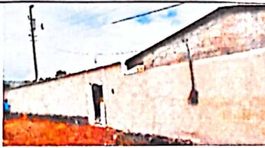
Foto 5: MURO Y REPELLO CONCLUIDO
